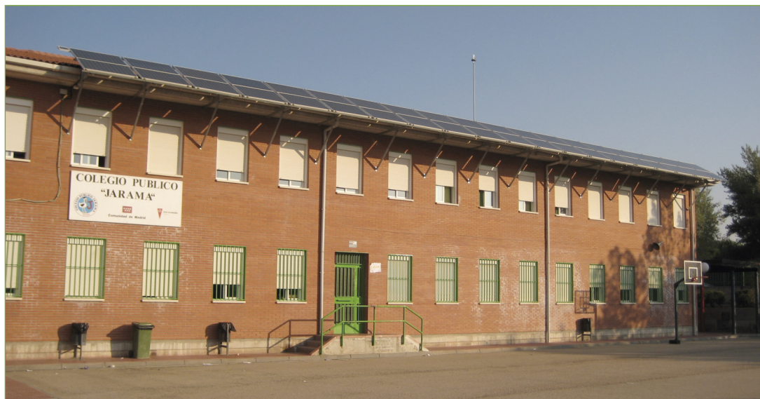
Figura 16. Instalación solar fotovoltaica en Colegio Público "Jarama".
