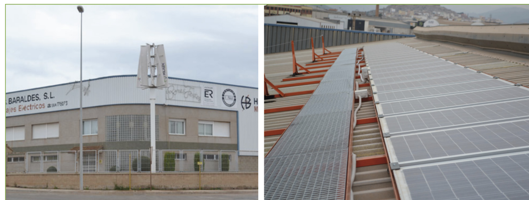
Figura 18. Instalación del sistema híbrido.
